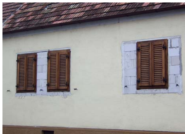
Abb. 27: großformatige Fenster aus den 60/70er-Jahren werden durch maßstabsgerechte ersetzt, Purbach
