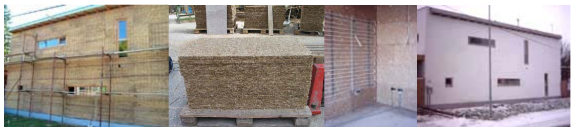
Abb. 30: Passivhaus mit Schilfdämmung, Schilfgranulatplatten und Wandheizung auf Schilfplatten
