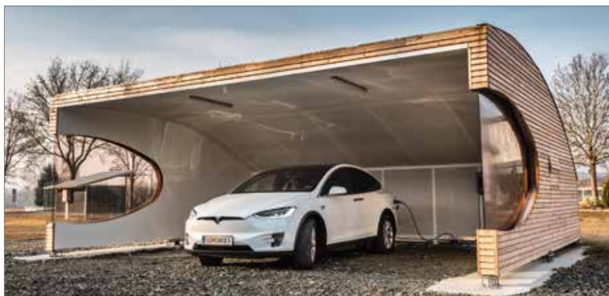
■ oben: Carport mit Ladestation in Ollersdorf (Foto: Zentrum für Ökomobilität 2.0)
