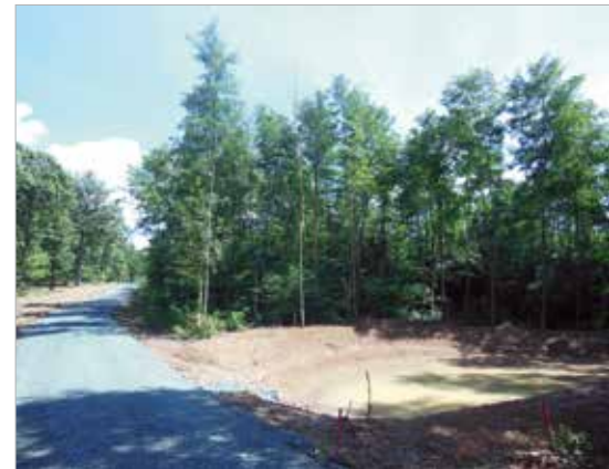
■ oben: neu gebaute Forststraße mit Feuchtbiotop
