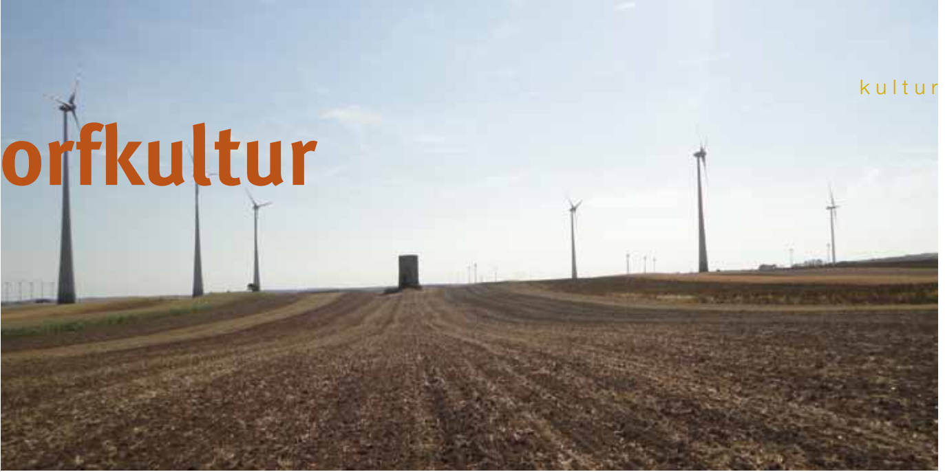
■ Der Heideturm bei Kittsee, ein spätmittelalterlicher Wach- und Glockenturm – eingerahmt und überragt von Windenergieanlagen
