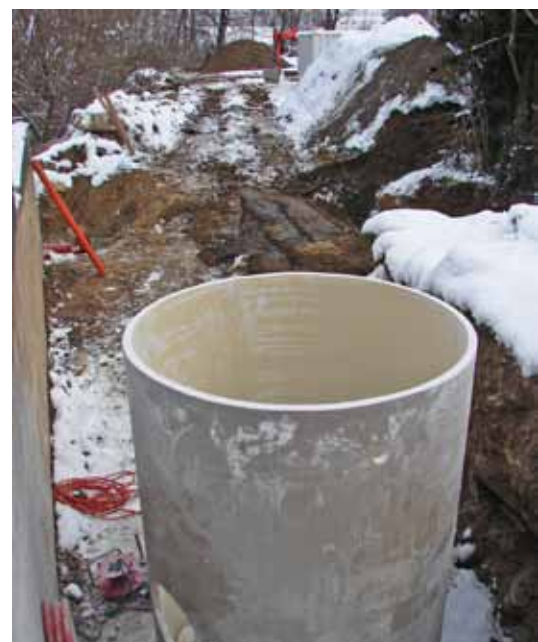
Abb. 45: Hier entsteht ein Aufzucht- gerinne für die Lafnitz-Äsche
