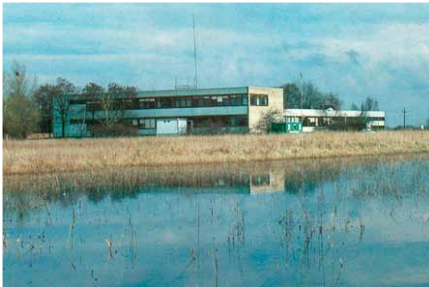
Abb. 9: Neue Biologische Station, Illmitz
