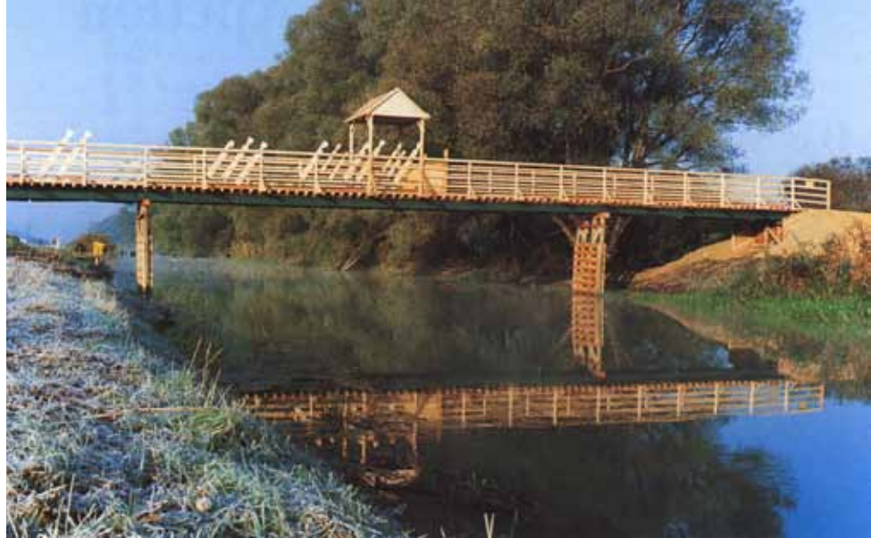
Abb. 114: Die Brücke von Andau verbindet AT und HU am Grünen Band
