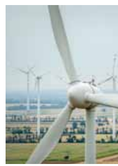
Foto: Energie Burgenland
