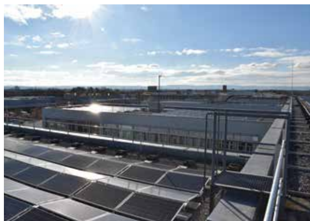
■ PV-Anlage auf dem Dach des TZ Eisenstadt
